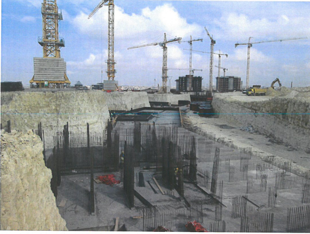
Tema İstanbul 1 Sitesi Kaba Yapı İnşaat İşleri tünel kalıp imalatı.
