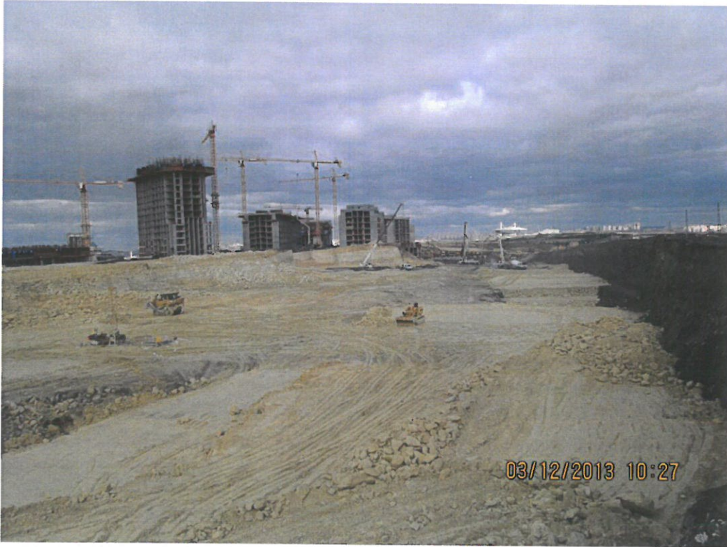
Tema İstanbul 1 Sitesi Kaba Yapı İnşaat İşleri tünel kalıp imalatı ve temel kazıları.
