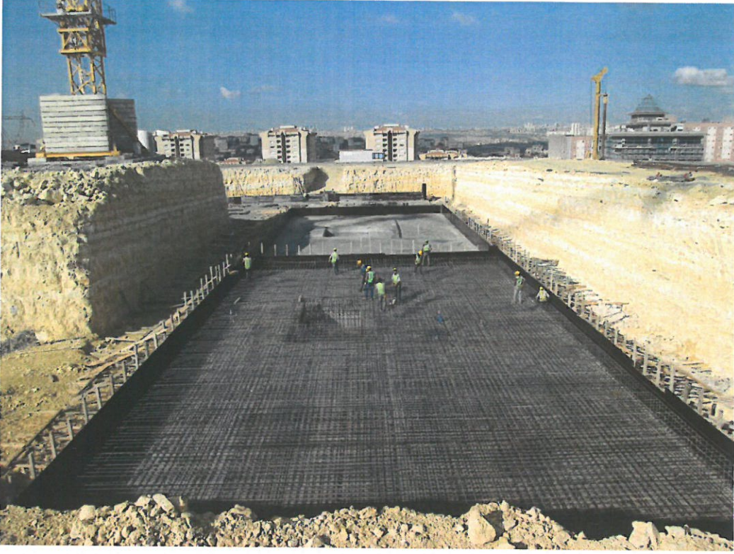
Tema İstanbul 1 Sitesi Temel çalışmaları. Eosen karbonatlılarına ait kireçtaşı ve killi-kireçtaşı birimleri içinde yerleşmiştir.
